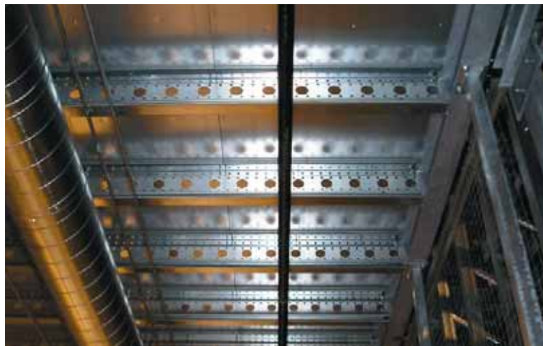
Cliente escolheu um acabamento inferior galvanizado G60 para obter refletividade de luz, adicionou força e proteção contra incêndio.
